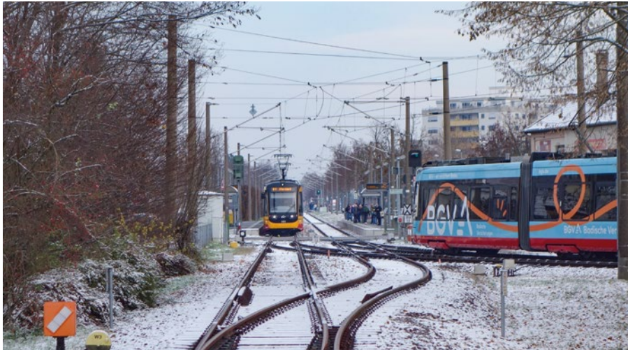
3: Verknüpfung der Infrastrukturen nach BOStrab mit EBO in Karlsruhe Neureut Quelle: Günter Koch
