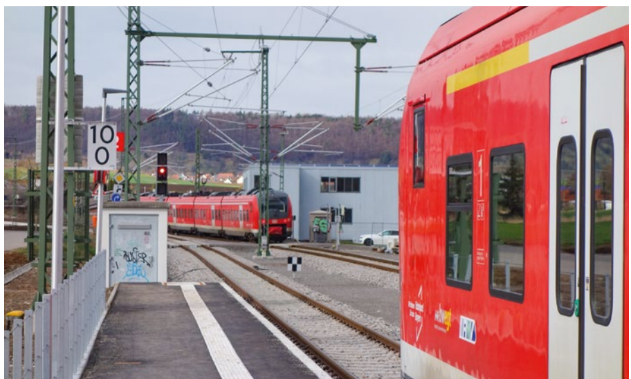
4: Ausgebaute und neu elektrifizierte Ammertalbahn Tübingen – Herrenberg, ein Lückenschluss im Netz Quelle: Günter Koch
