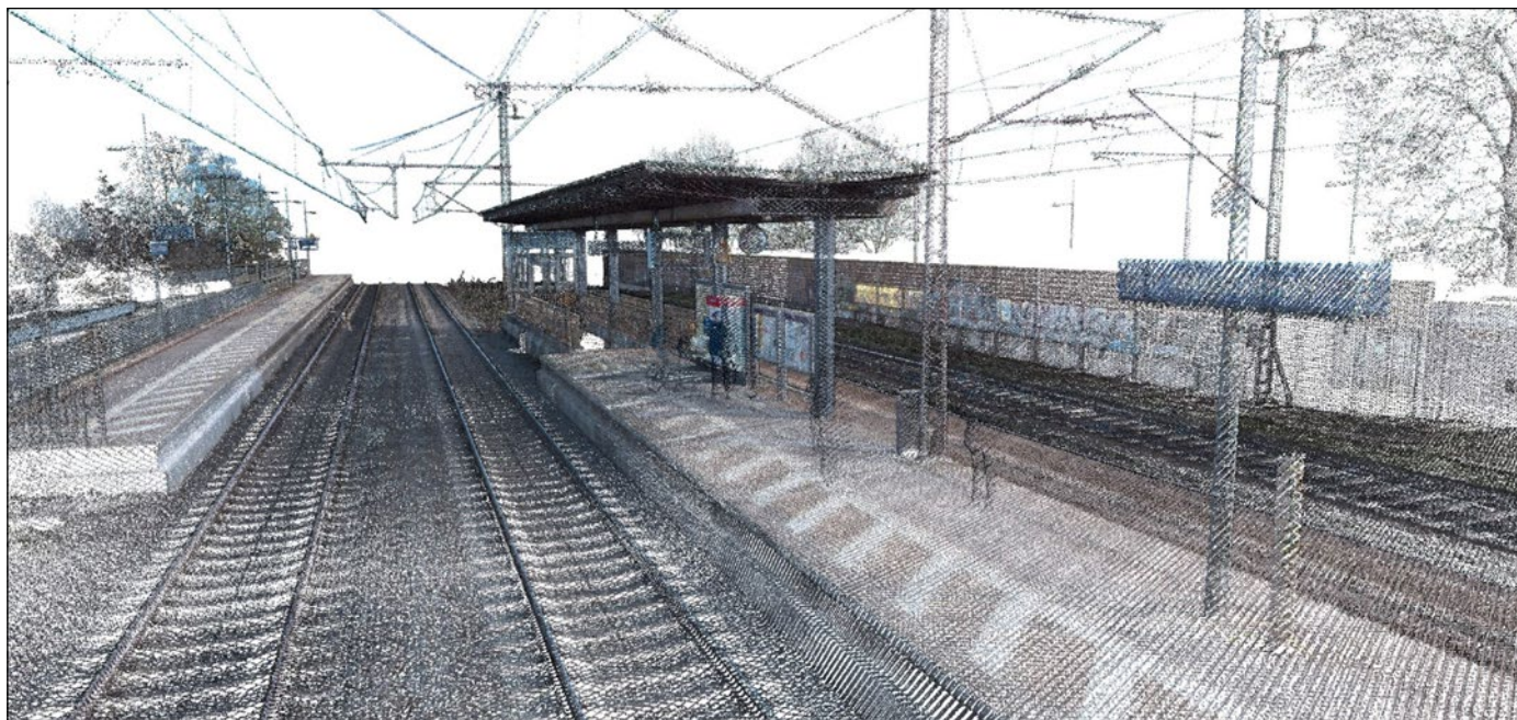
Abb. 2: Ansicht Station in georeferenzierter Punktvolke aus MSS-Befahrung
