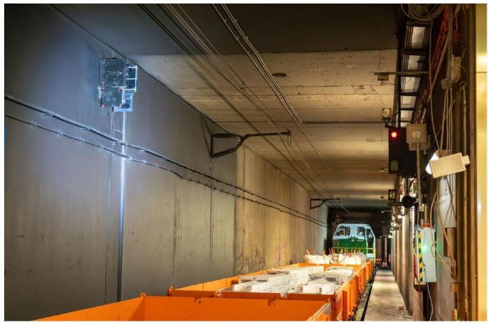
Abb. 3: Bauzug auf der S-Bahn-Stammstrecke im September 2024, mit abgedeckten ETCS-Halttafeln (links, Rücken an Rücken) und Lichthauptsignal (rechts)
