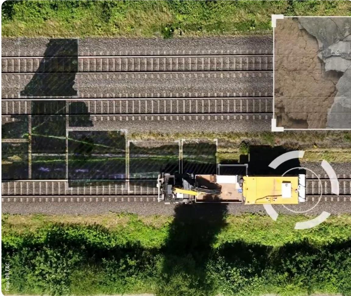
Beim Georadar werden elektromagnetische Wellen über einen Sender in den Untergrund gesendet. An der Grenze von unterschiedlichen Materialien wird das Signal (teilweise) reflektiert und von einem Empfänger aufgezeichnet. Durch die fortlaufende Bewegung der Antenne über die Oberfläche ist eine kontinuierliche Erfassung des Untergrundes möglich. Abhängig vom Auflösungsvermögen wird in bestimmten Abständen (Scans/m) ein Messwert erzeugt.
