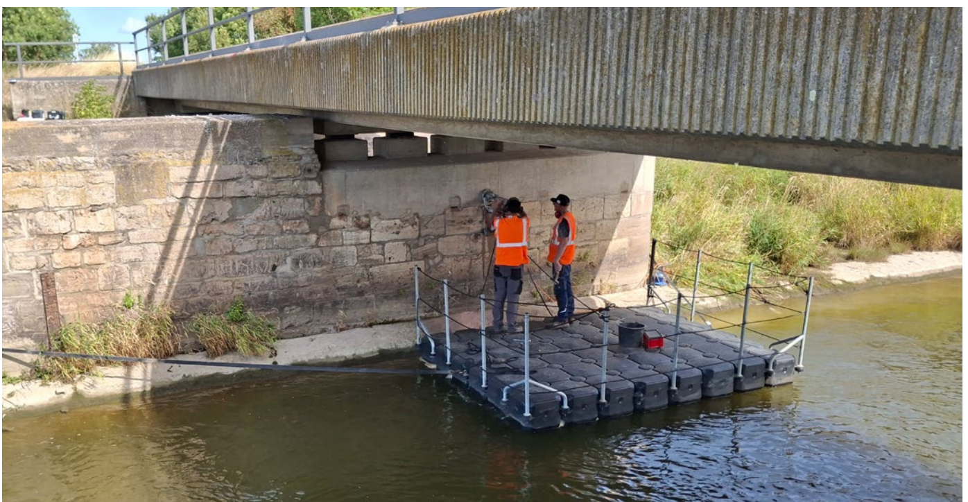
Abb. 4: Bauwerksdiagnostische Untersuchungen unter Zuhilfenahme eines Ponton
