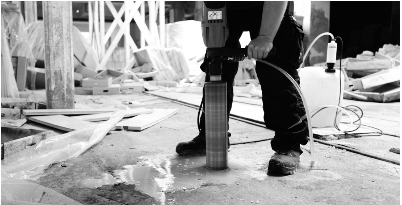
Abb. 3: Für die Untersuchung der Bausubstanz werden Probenahmen und Geometrieerkundungen mittels Kernbohrungen durchgeführt.
