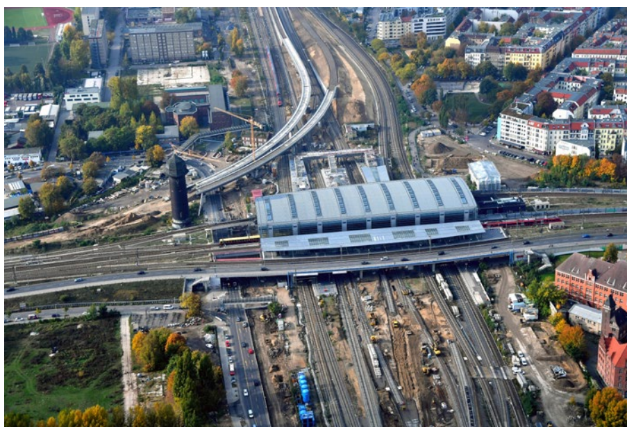
1: Baustelle Nahverkehrsknoten Berlin Ostkreuz
